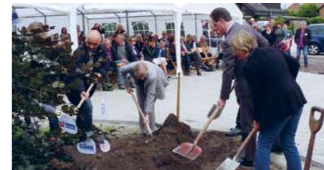
→ Neubau am Glummweg
