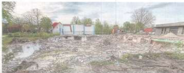
Platz für Neues entsteht zurzeit dort, wo einst die Wäscherei der Werke stand.
