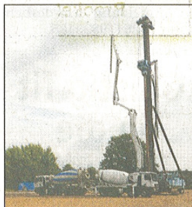
Große Maschinen arbeiten am Fundament für den Neubau.
