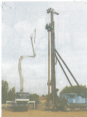
Große Baumaschinen sorgen kurzelt für ein sicheres Fundament der Neubauten am Glummweg
