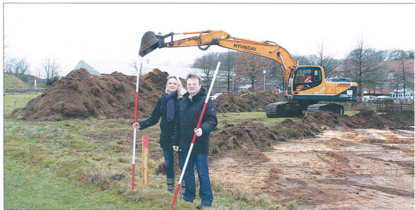
Der Bau hat begonnen: Anja Rirck, Projektleitung für die Tagesförderstätte, und Friedhelm Sager, Abteilungsleiter für den Bereich Wohnen, freuen sich über den ersten Baggereinsatz und den Start für ein neues Wohnprojekt.
