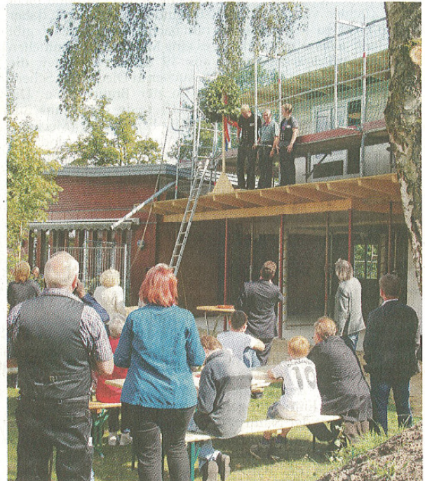
Auf dem Gelände der Rotenburger Werke wurde jetzt Richtfest gefeiert Foto: Hartmann
