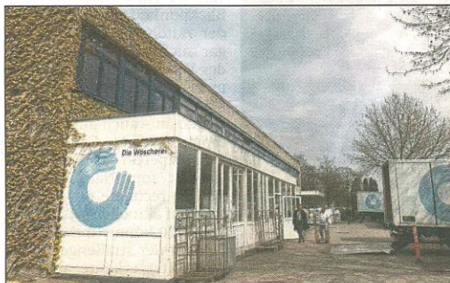
Die Wäscherei auf dem Werke-Gelände „glänzt“ mit dem Charme der 70er-Jahre und ist inzwischen viel zu klein für den Betrieb.
