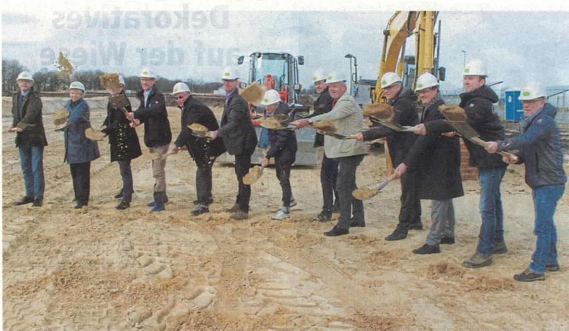
Für den ersten Spatenstich packen alle mit an: Die Rotenburger Werke starten den Neubau einer Wäscherei im Gewerbegebiet Hohenesch. 9,5 Millionen Euro soll der Bau kosten, der im ersten Quartal 2019 fertiggestellt sein soll. Foto: Henning Leeske
