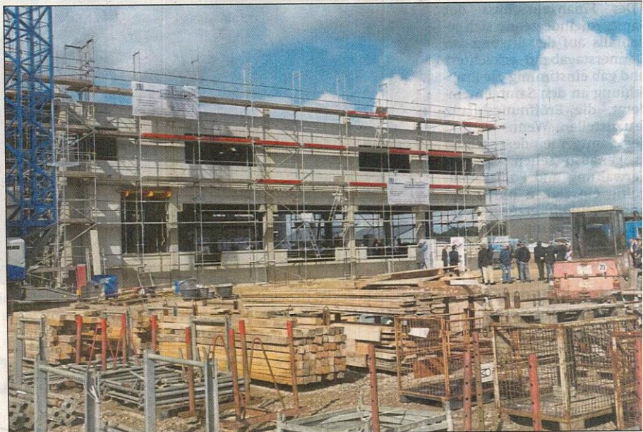
Das „gigantische Ausmaß“ ist schon zu erahnen. Der Rohbau der Wäscherei steht, das Richtfest ist vollzogen. Anfang des zweiten Quartals 2019 wird hier tonnenweise Wäsche gewaschen. - Foto: Ujen
